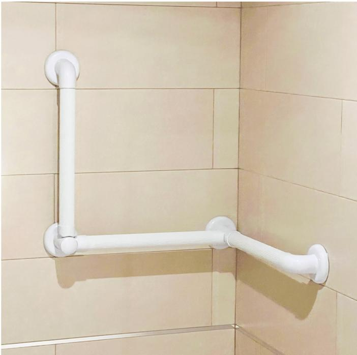
Con RAIL SYSTEM las instalaciones para prevenir caídas se pueden hacer a medida. Cualquier longitud de pasamanos es posible empalmando tramos rectos con ayudas de piezas de unión. Si fuera necesario, las barras rectas suministradas en tramos de 100 cm, se pueden cortar fácilmente a la medida deseada y terminarlas con piezas finales. No importa si hay que salvar un rincón en ángulo de 90º, con RAIL SYTEM es posible!
